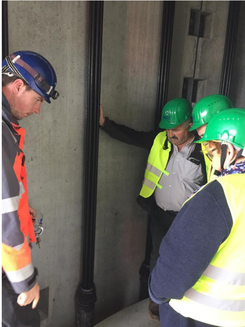
Visite de Chantier du parc de Champcourt (wpd) le 30 Mai 2019 avec le conseil municipal de Pleine-Selve
